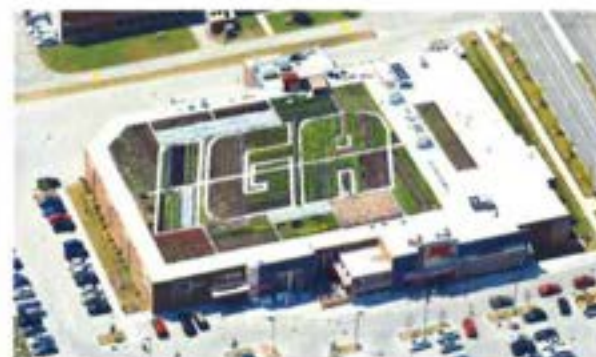
Fig. 154. Toiture verte et blanche à forte IRS (Source : IGA).
