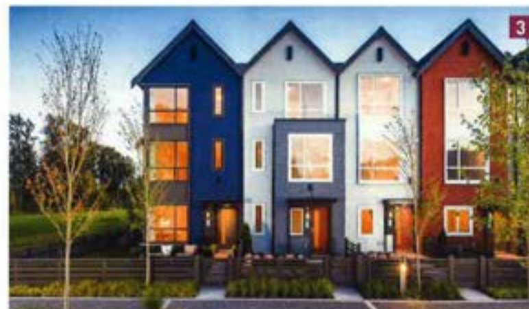
Fig. 208. [3] 4-Plex à Coquitlam, Colombie-Britannique. (Source : Mosaic Homes)
