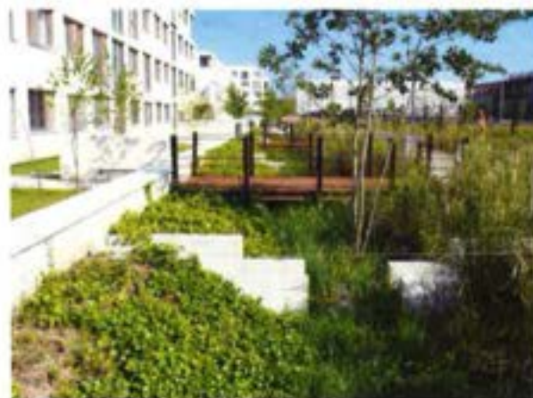
Fig. 161. Noue végétalisée permettant une rétention des eaux sur le site (Source : BrueiDelmar).
