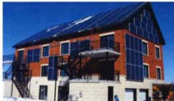
Fig. 151. Production d'énergie propre, six-plex net zero, Laval (Source : Construction Voyer).
